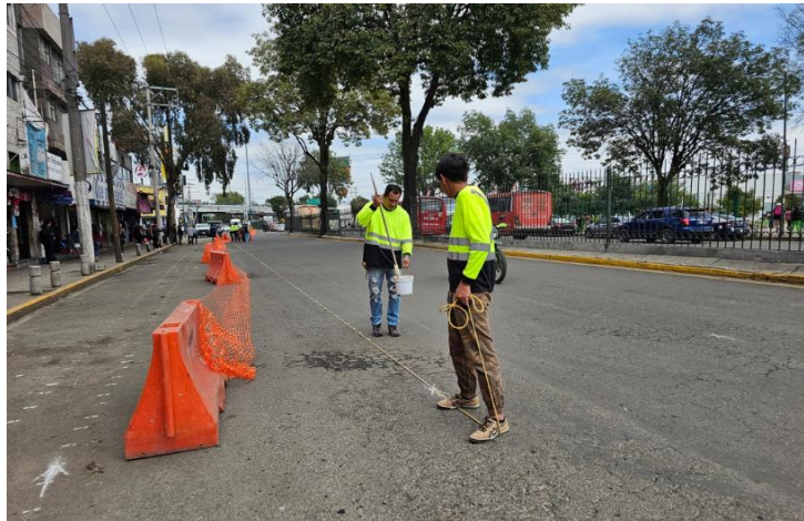
Figura 73 Inicio de trabajos de construcción de la ciclovía (Primer etapa)
